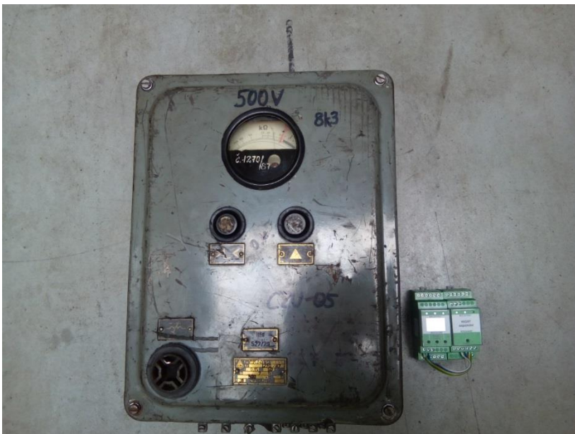
Rysunek 3 – porównanie pierwotnego przekaźnika kontroli stanu izolacji typu CZU-05 i HIG97
